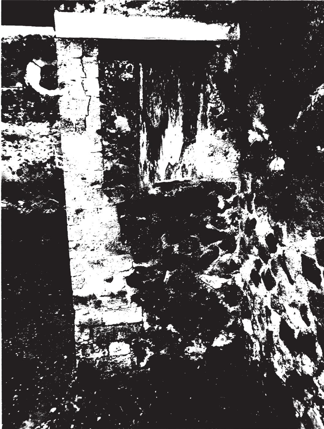
**Figura 10 PARETE OVEST-AMBIENTE 10: PILASTRO CON BLOCCHI DI TUFO MODERNI DA SOSTITUIRE**
